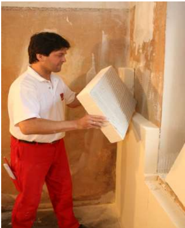
Kasil Pura-eristeen asennus.
